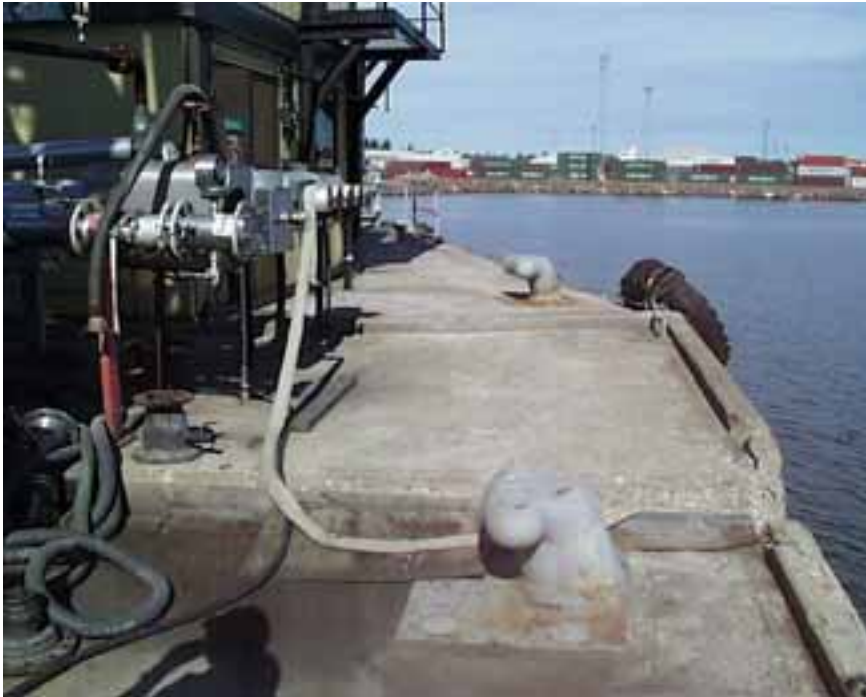
Kuva 20. Laituri 1, lastausalueen betonireunuksella varustettu keräilyalue.
