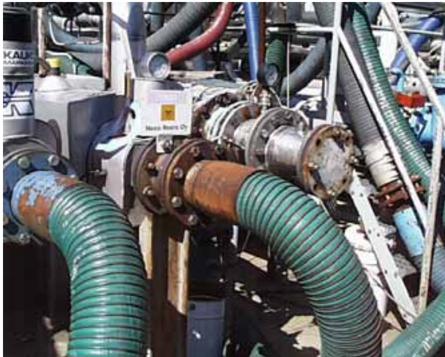
Kuva 14. Dynea Finland Oy:n fenolin lastausyhde
