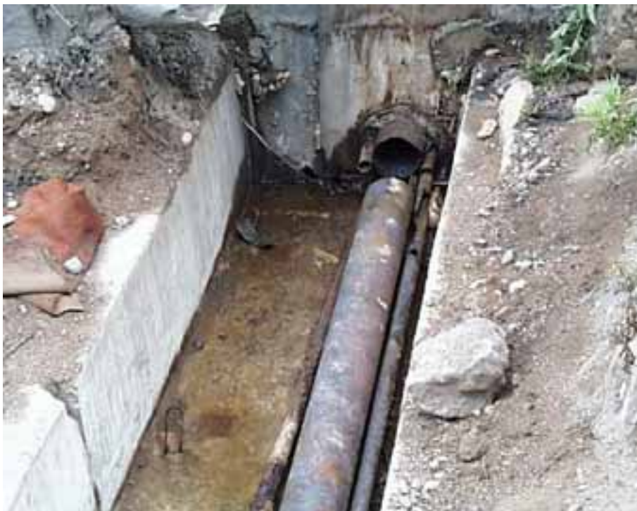
Kuva 26. Tehdasalueelle menevä putkistokanaali aukaistuna.
