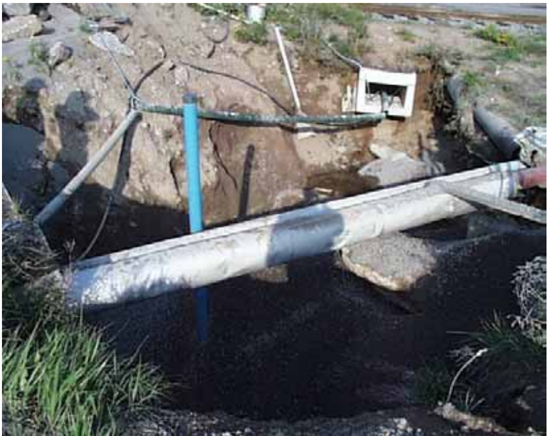
Kuva 6. Sininen pystyssä oleva putki on havaintoputki PR23
