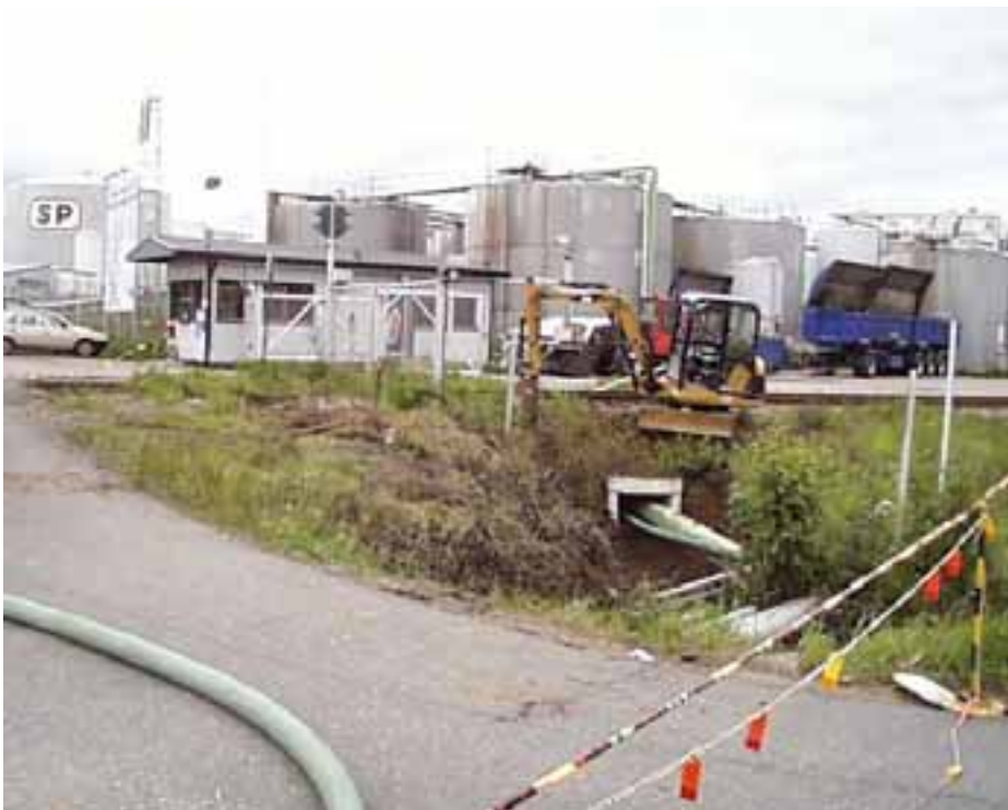
Kuva 2. Saastuneen maaperän poistoa kaivinkoneella.
